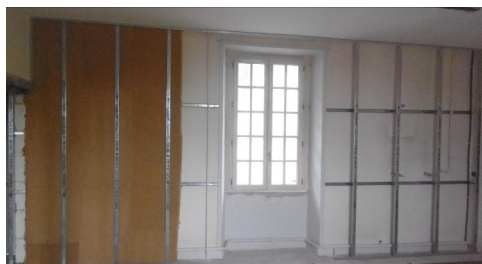
Chantier isolation laine de bois
